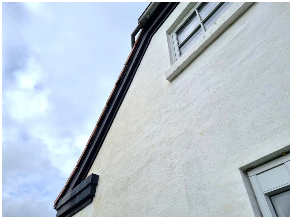
Figur 5-76 Beboelseshusets østvendte gavl. Der er ingen væsentlige mellemrum mellem tagsten og gavlen, og der er ikke observeret krads- eller slidmærker på gavlen langs taget.
