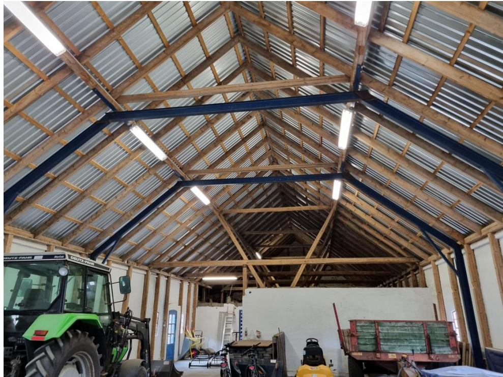
Figur 5-131 Den øvrige del af GR11B fotograferet imod vest. Denne del af bygningen udgøres af ét stort rum, og er åbent ind til bygningens eget loft og loftet over GR10B.
