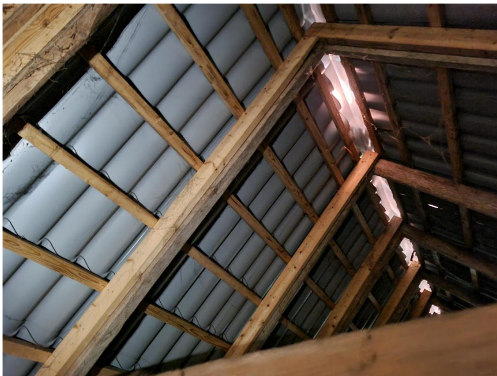
Figur 5-82 Stuehusets loftrum fotograferet imod den sydvendte gavl. Loftet udgøres af ét stort rum, og der er ikke etableret undertag under tagdækningen.
