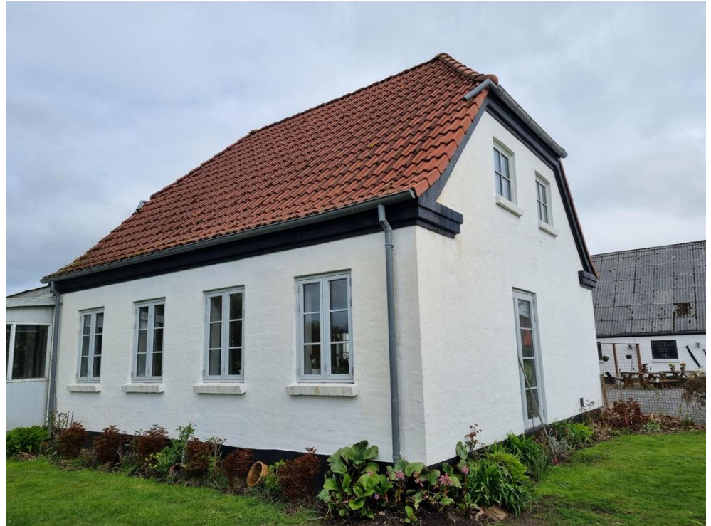
Figur 5-75 Beboelseshuset fotograferet i nordvestlig retning fra haven. Der blev udvendigt ikke fundet nogen synlige tegn på tilstedeværelsen af flagermus, og der blev ikke fundet mellemrum eller lignende, der giver adgang til tagkonstruktionen.
