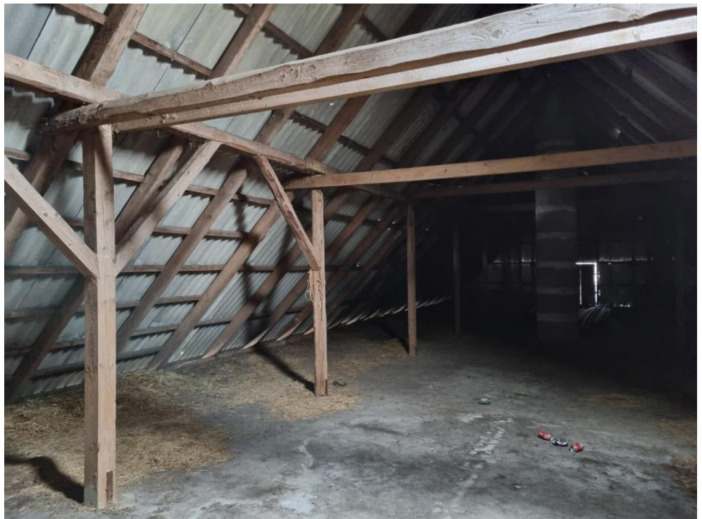
Figur 5-87 Staldbygningens loftrum fotograferet imod nordvest. Loftrummet er nærmest helt tomt, intet undertag og ingen mindre hulrum eller lignende, der potentielt kan udgøre yngle- eller rastesteder for flagermus.
