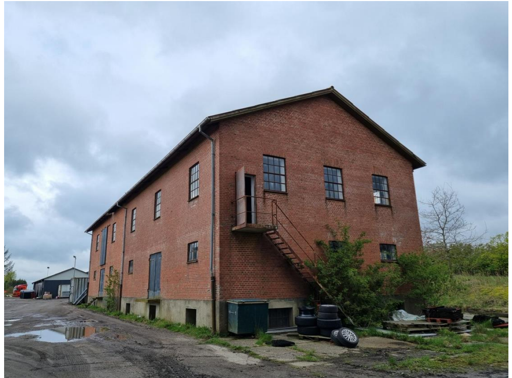
Figur 5-94 GR03B fotograferet imod nordøst. Flere vinduer på overetagen er i stykker og døren hertil stod på besigtigelsestidspunktet helt åben. I tagryggen ved bygningens sydvendte gavl, giver en åbning adgang ind under taget for flagermus.
