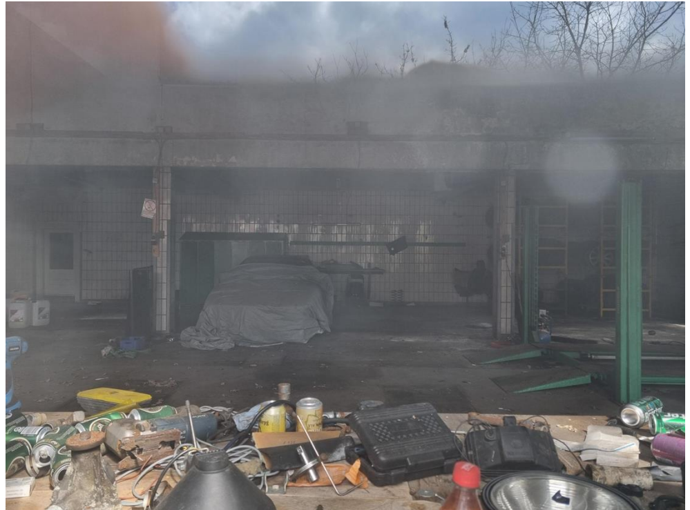
Figur 5-110 Den sydlige del af stueetagen af GR08B fotograferet imod nord gennem vindue. Denne del af bygningen fremstår forladt, men har karakter af autoværksted.
