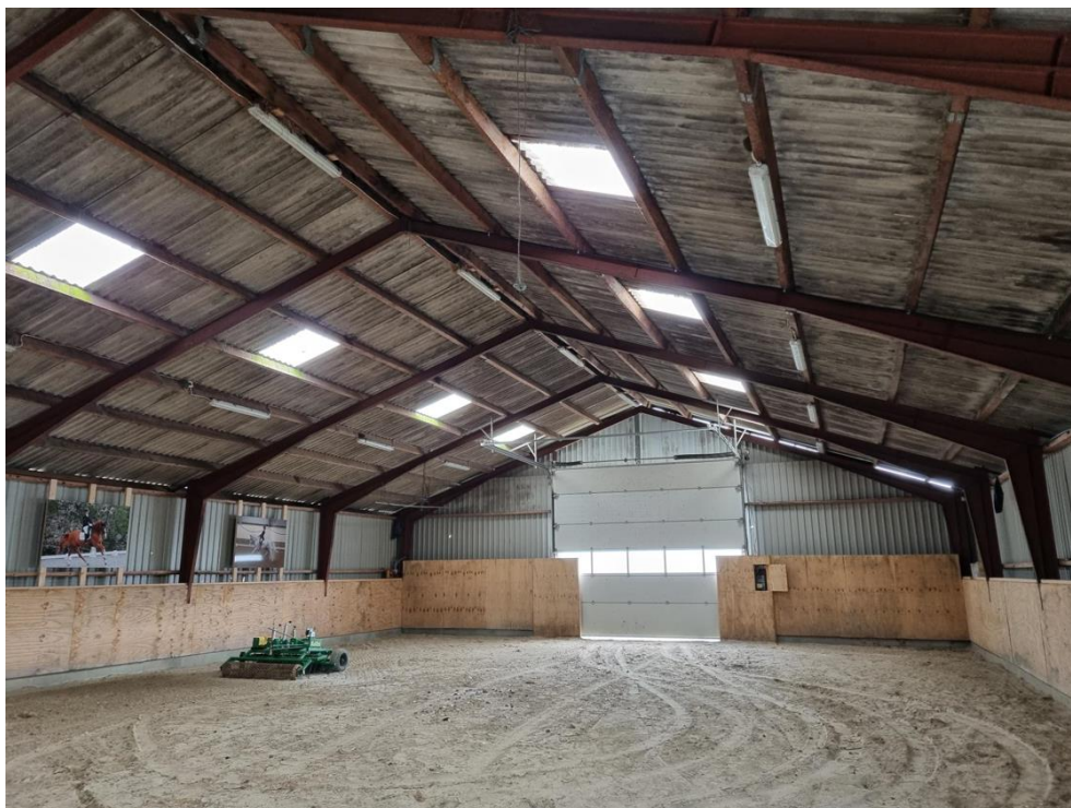
Figur 5-93 GR02B rummer en ridebane og udgøres af ét stort, åbent rum. Bygningen har intet undertag eller isolering, og der blev ikke observeret hulrum eller lignende der kan udgøre yngle- eller rastesteder for flagermus.
