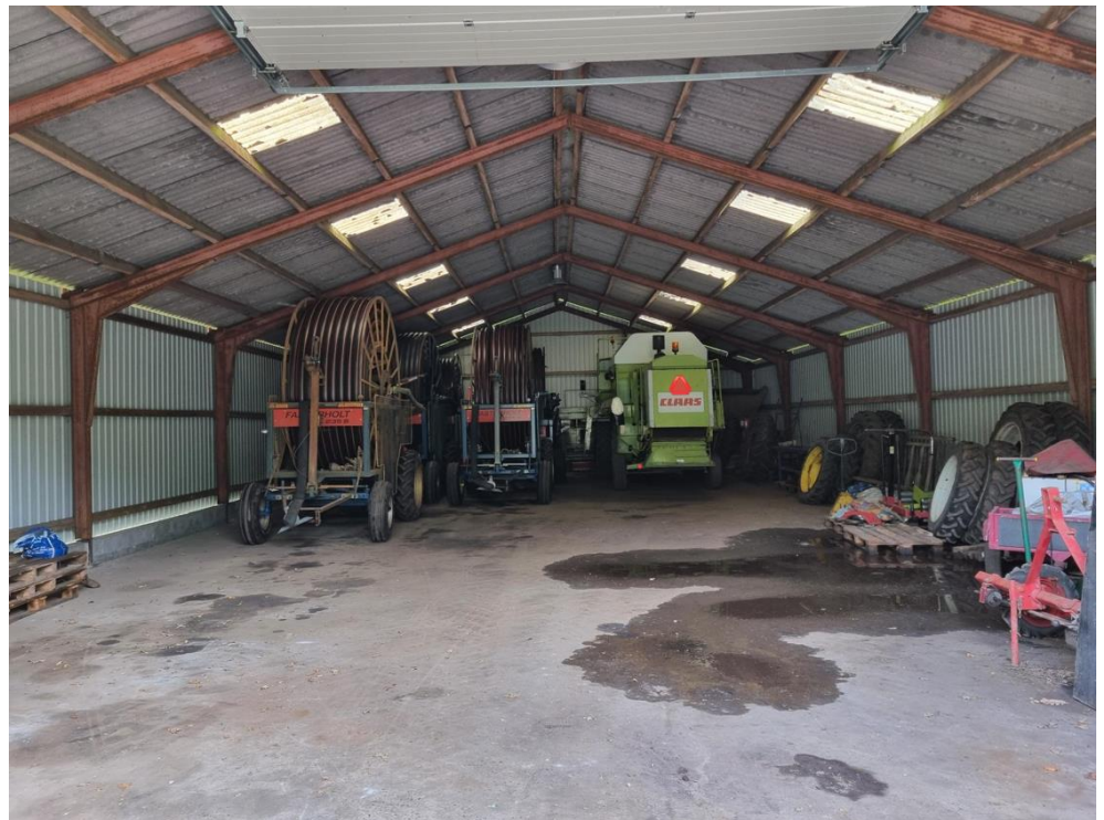
Figur 5-135 Maskinhuset bruges til opbevaring af udstyr til landbrugsdrift, og udgør ét stort rum.
