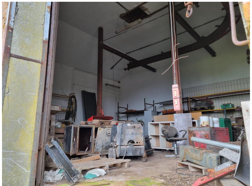
Figur 5-115 Et åbent rum i den østlige del af øverste etage i GR08B. Loftbeklædningen er flere steder ødelagt og åben, og der er således adgang direkte ind til tagkonstruktionen.
