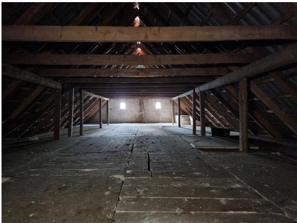
Figur 5-82 Stuehusets loftrum fotograferet imod den sydvendte gavl. Loftet udgøres af ét stort rum, og der er ikke etableret undertag under tagdækningen.
