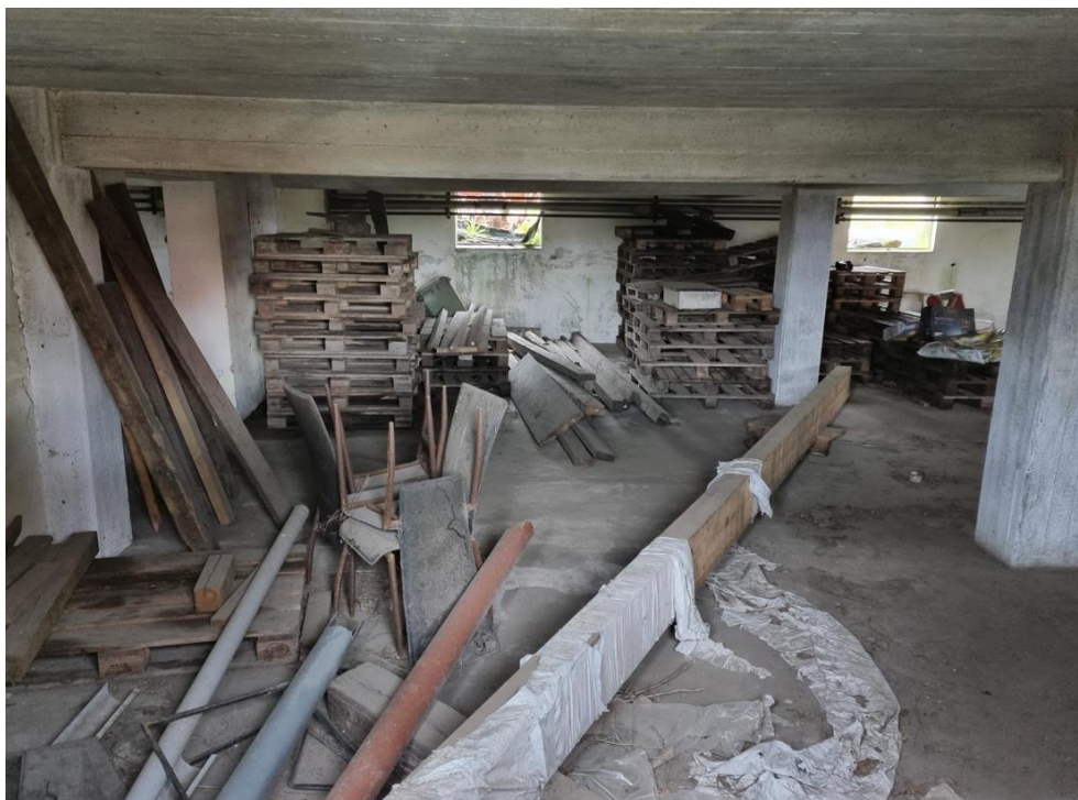
Figur 5-95 Den midterste del af kælderen i GR03B, hvor der bl.a. er opbevaret byggematerialer, paller og gammelt inventar.
