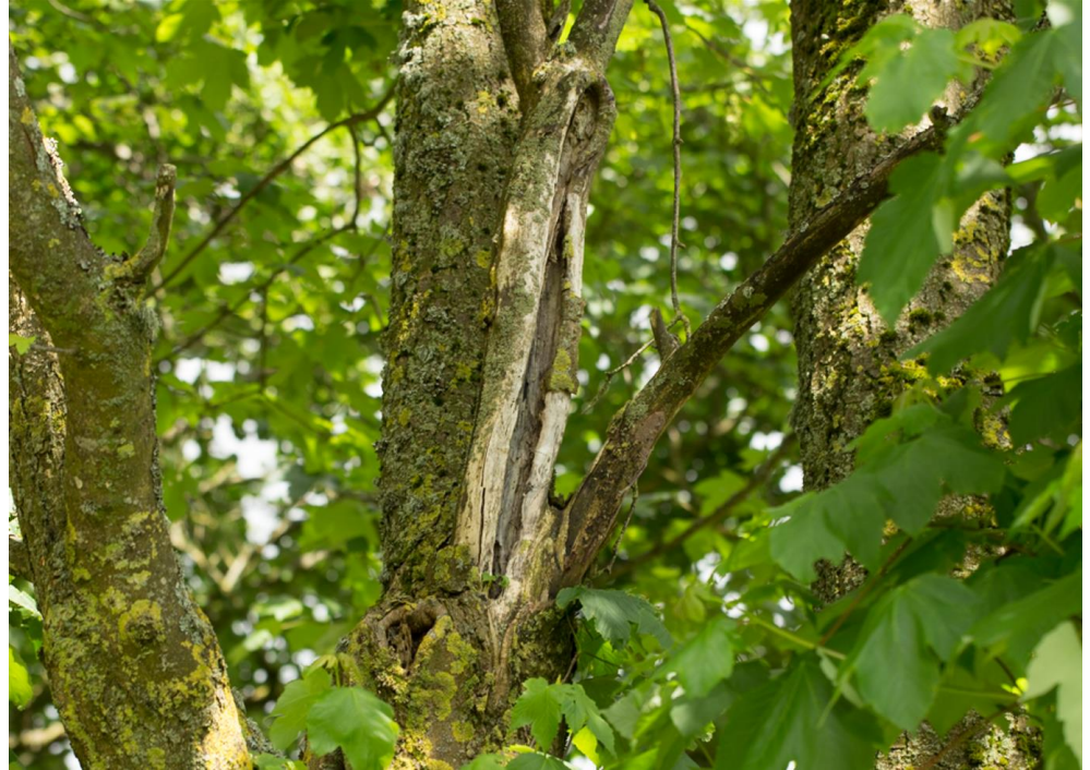
Figur 5-61 Sprække og åbning ind i stamme på ahorntræ. Sprækken udgør næppe et egnet yngle- eller rastested for flagermus, men åbningen i stammen kan ikke udelukkes at lede til et hulrum, der kan være egnet som yngle- eller rastested for flagermus.
