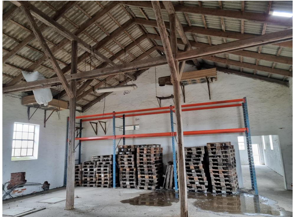
Figur 5-100 Den nordlige halvdel af overetagen i GR03B fotograferet imod sydøst, hvor der ligeledes opbevares paller. På gulvet ses vandsamlinger fra store huller i taget.
