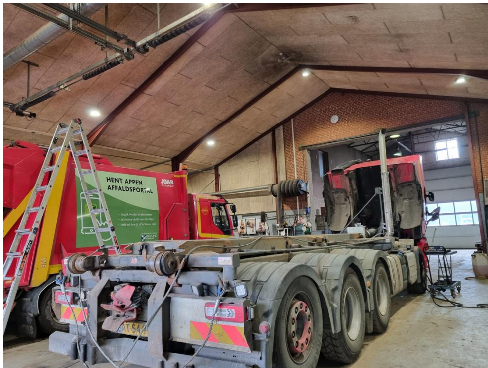
Figur 5-107 GR06B bliver i sin nuværende funktion brugt som autoværksted til lastbiler. Loftet er beklædt med træbeton.
