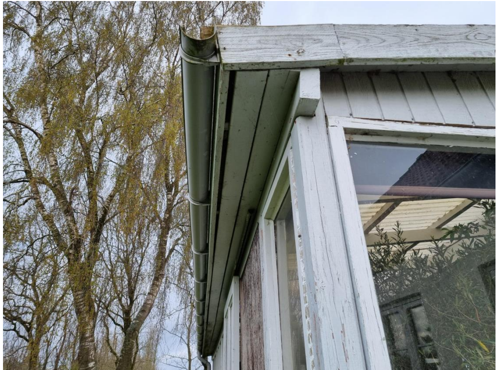
Figur 5-78 Udhængsbrædder med 1-2 cm mellemrum langs udestuens sydside, hvor der skabes et mindre hulrum i tagkonstruktionen. Der blev ikke observeret kradse- eller slidmærker ved åbning, og denne vurderes samtidigt at være svært tilgængelig for flagermus, da det er svært at lande og lette herfra.
