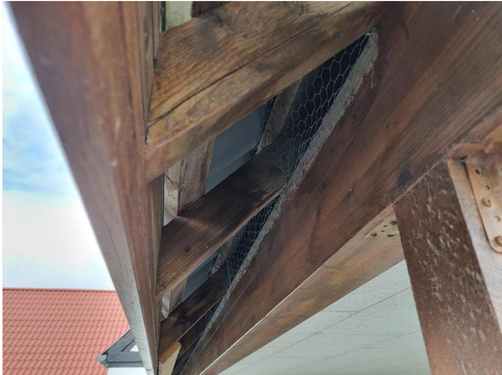
Figur 5-91 Langs hele garagens tag er der afspærret med kyllingenet, og der er således potentiel adgang ind til tagkonstruktionen og det afspærrede loftrum for de mindste flagermusarter.
