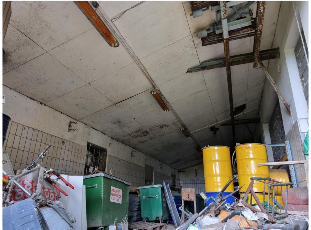
Figur 5-115 Et åbent rum i den østlige del af øverste etage i GR08B. Loftbeklædningen er flere steder ødelagt og åben, og der er således adgang direkte ind til tagkonstruktionen.
