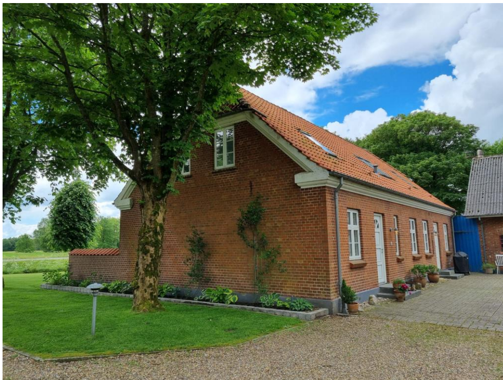
Figur 5-117 GR09B fotograferet imod sydvest. Bygningen har gavle vendt direkte imod øst og vest, men har intet loftrum, da overetagen er til kip og bruges til beboelse.
