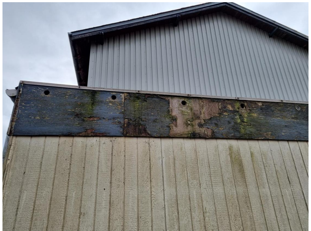
Figur 5-112 Gammel skurvogn på vestsiden af GR08B, hvor flere ventilationshuller mangler riste og derved skaber en potentiel adgang for flagermus ind i tagkonstruktionen.
